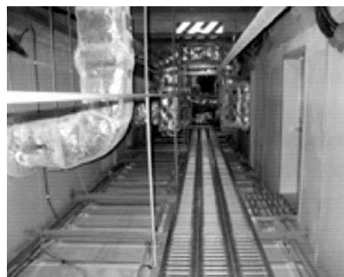
(2) 天井階メンテナンススペース
