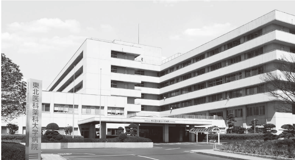
福室キャンパス 東北医科薬科大学病院 本館
