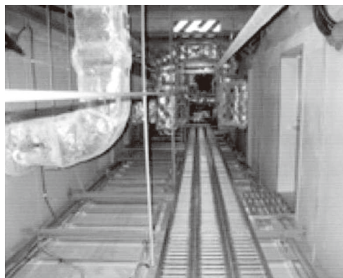
(2) 天井階メンテナンススペース
