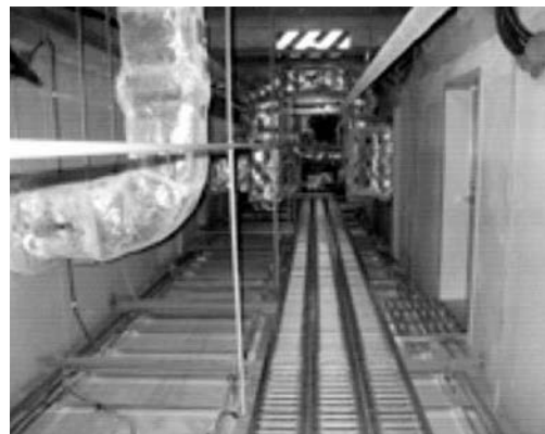
(2) 天井階メンテナンススペース
