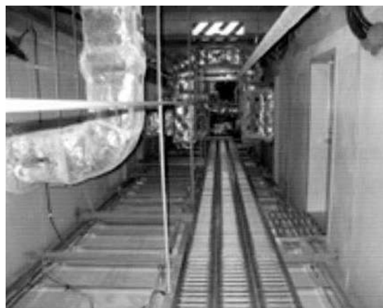
(2) 天井階メンテナンススペース
