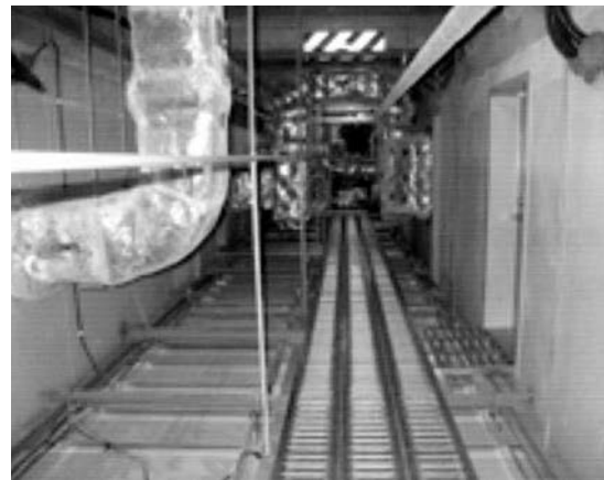
（2） 天井階メンテナンススペース
