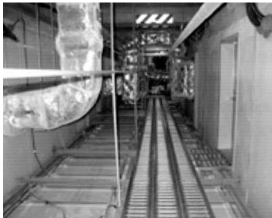
(2) 天井階メンテナンススペース
