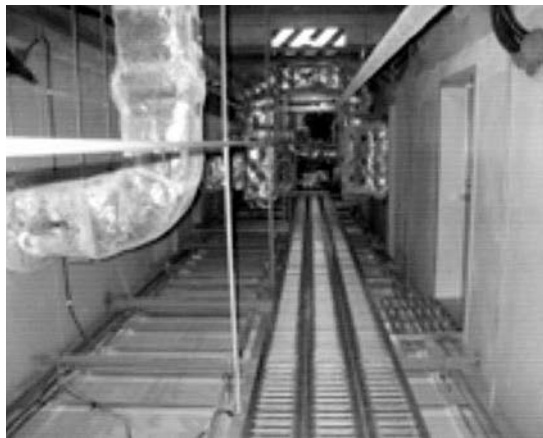
（2） 天井階メンテナンススペース
